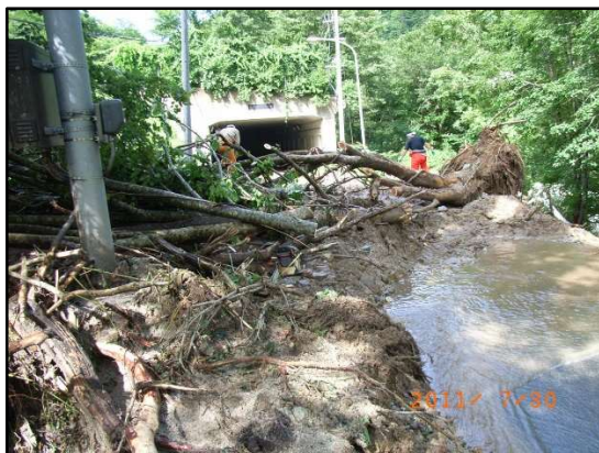
下大戸沢スノーシェッド付近
